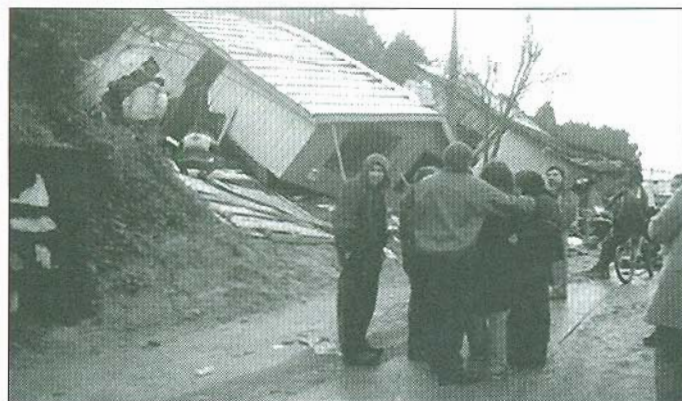
Fig. 17. Derrumbes Co La Pólvora, calle Pelantaro. Siete familias afectadas y 3 muertos. Foto: 01-07-05
