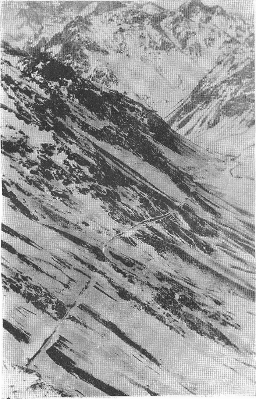
Fig. 7. Ferrocarril internacional. Alto valle del río Aconcagua.
